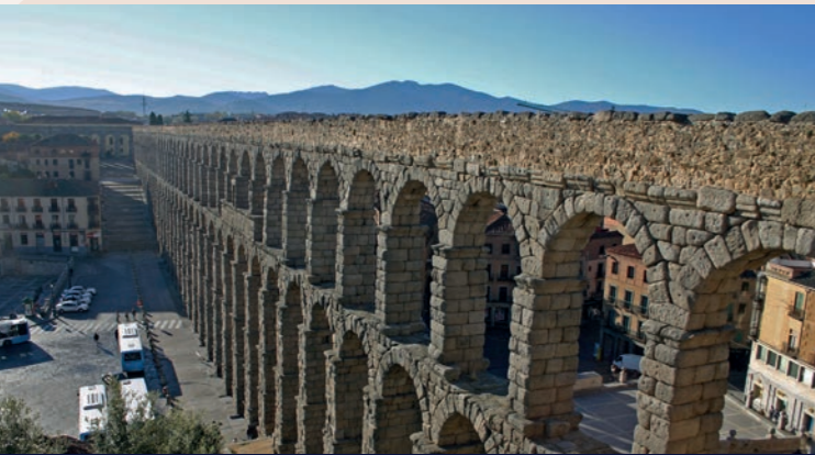
Aquäduktbrücke in Segovia (Spanien) – nur Teil einer römischen Wasserversorgung oder auch eine Demonstration römischen Machtanspruchs?
