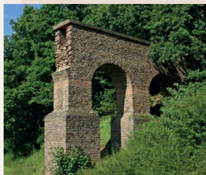
Mechernich-Vusse: Über Originalbefunden rekonstruierte Aquäduktbrücke
